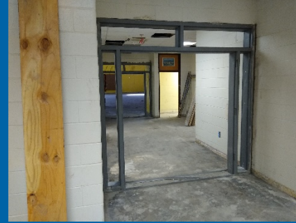
Install Corridor Door Frames
